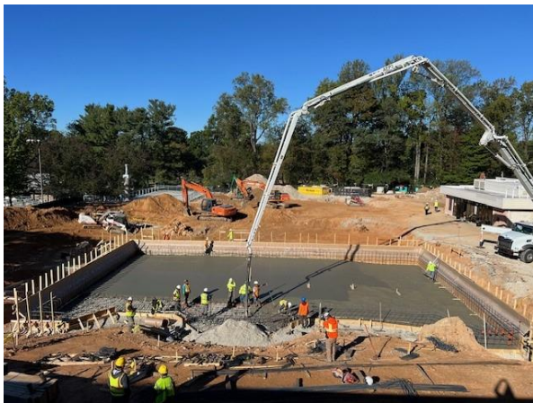
Wellness Pool Concrete Pour
